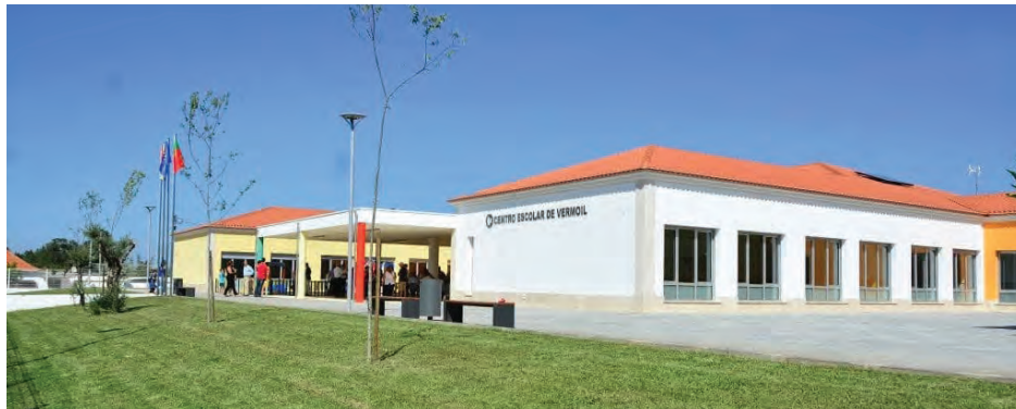
●Junta de Freguesia de Vermoil já iniciou contactos para identificar terrenos que permitam a ampliação do Centro Escolar
